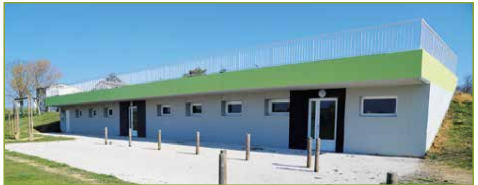
● Les vestiaires des Mesnils ont été remis à neuf.
