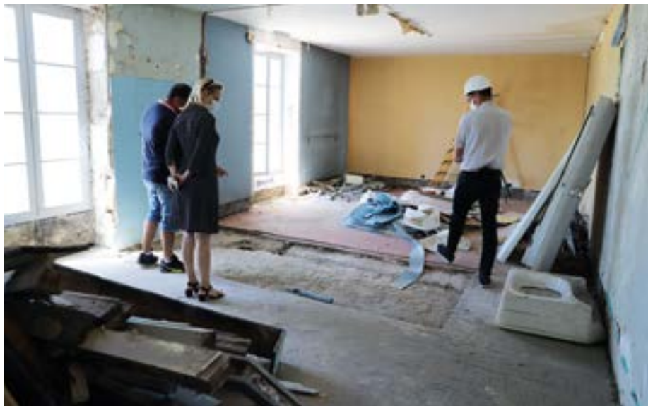
● Visite lors de la reprise du chantier.
