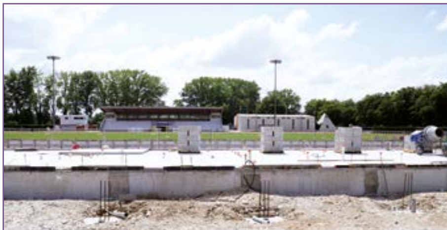
• Le service maçonnerie a commencé à couler les premières dalles des nouveaux vestiaires.
