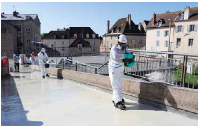
• Dernières finitions sur le parking des Terreaux avant sa réouverture aux usagers.
