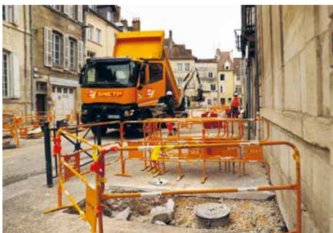
• De nouvelles canalisations en polyéthylène haute densité (PEHD) ont été introduites dans les conduites existantes depuis de simples "niches".
