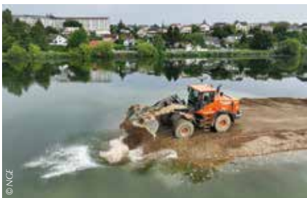
● Mise en place d'une grève sur le Doubs.
