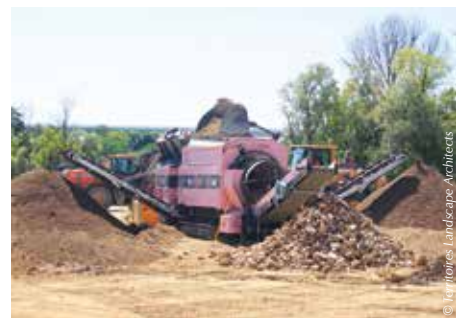
● Tri des matériaux par une cribreuse.
