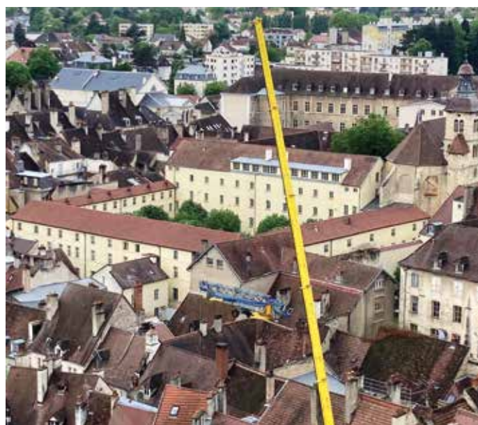
● Déplacement d’une grue lors d’un projet de réhabilitation de logement, rue des Arènes.
