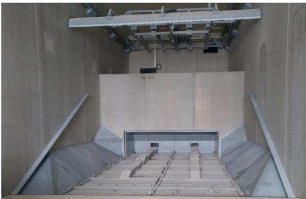
La trémie d'alimentation de la chaudière en combustible permet l'introduction régulée de la biomasse en fonction de la charge souhaitée et de l'humidité du bois.
