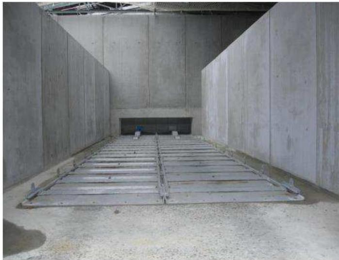
Un transporteur à raclette fermé emmène le combustible jusqu'à la chaudière. Il est constitué d'un ensemble « extracteur + carénage » en construction mécano soudée en acier recouvert d'une peinture de finition.
