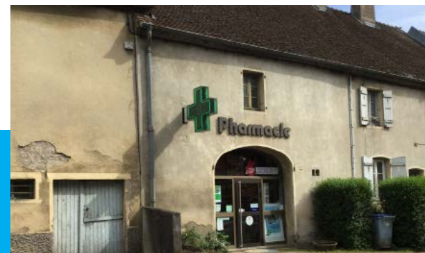
ENSEIGNE BIEN INTÉGRÉE À LA FAÇADE À MOISSEY
