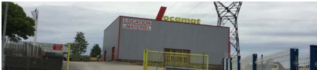
Enseigne sur toiture
