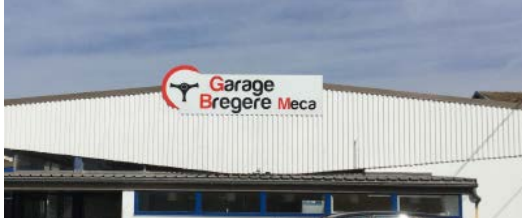
enseigne parallèle dépassant les limites du mur ou de l'égout du toit
