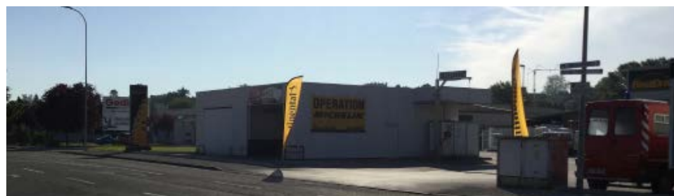
Enseigne scellée au sol ou installée au sol en surnombre le long d'une même voie
