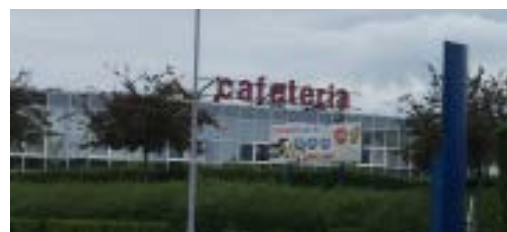
Enseigne sur toiture
