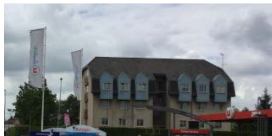
Enseigne scellée au sol ou installée au sol en surnombre le long d'une même voie
