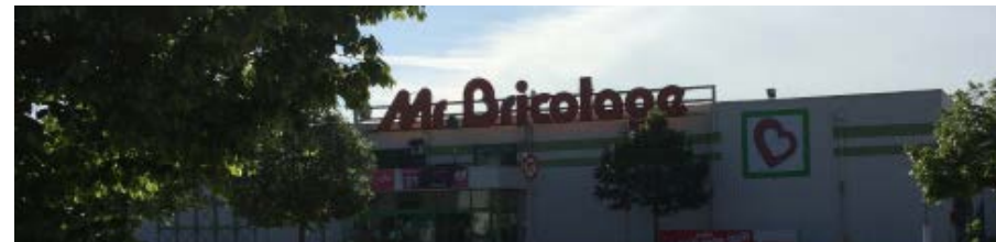
Enseigne parallèle dépassant les limites du mur ou de l'égout du toit
