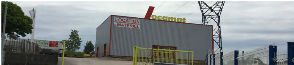
Enseigne sur toiture
