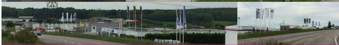
Enseigne scellée au sol ou installée au sol en surnombre le long d'une même voie
