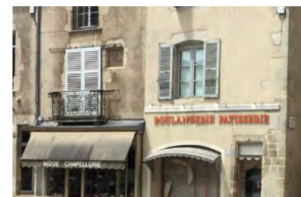
Enseignes parallèles bien intégrées aux façades
