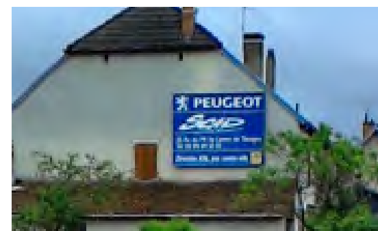
Dépasse des limites de l'égout du toit à Rochefort-sur-Nénon
