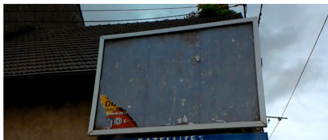
Dépasse les limites de l'égout du toit à Champvans
