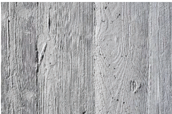
Exemple d'enduits à empreinte ou imprimé
