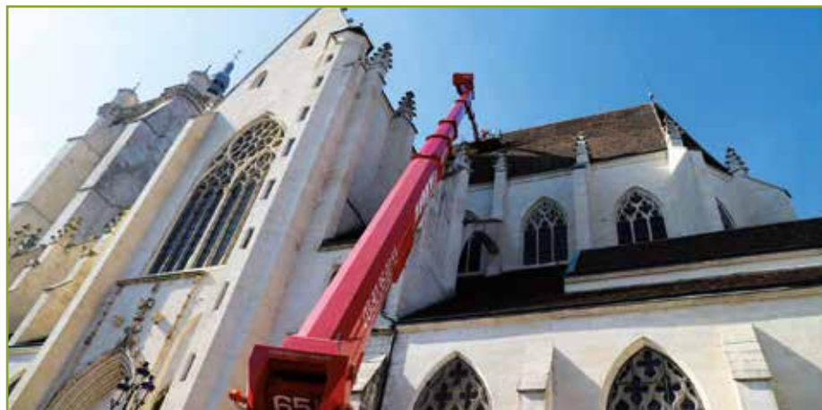
• Le remplacement des tuiles cassées a été réalisé au moyen d'une nacelle de 65 m de hauteur.
