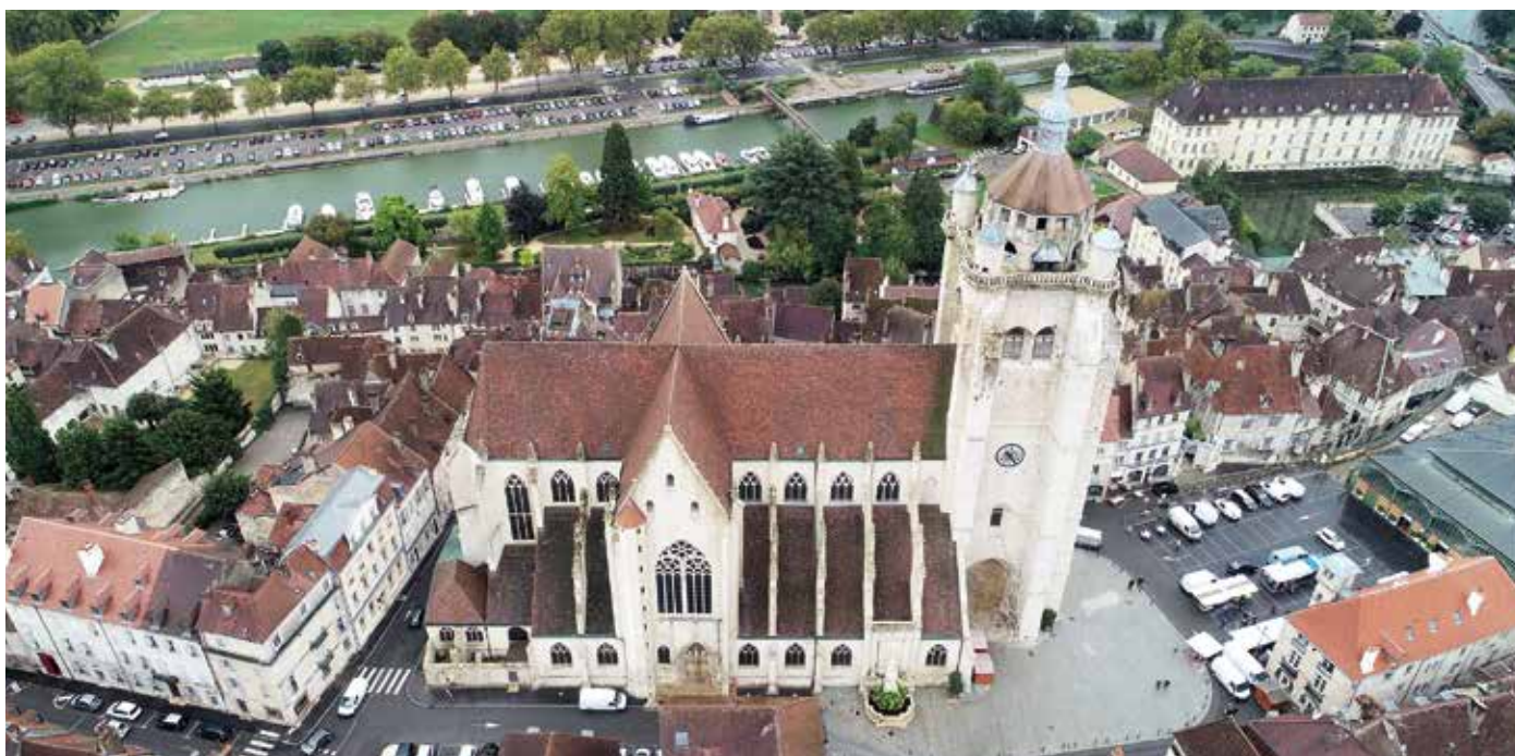
• Une opération importante de nettoyage et de maintenance sur la toiture de la Collégiale a eu lieu courant mars.
