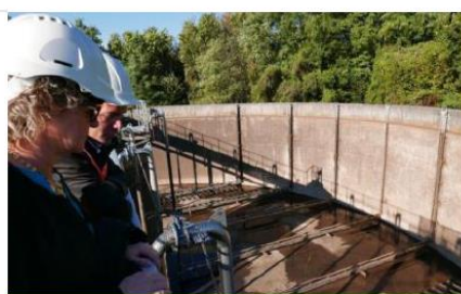
09.10.2016 Visite de la station d'épuration des eaux usées de Choisey à l'occasion du renouvellement des diffuseurs
