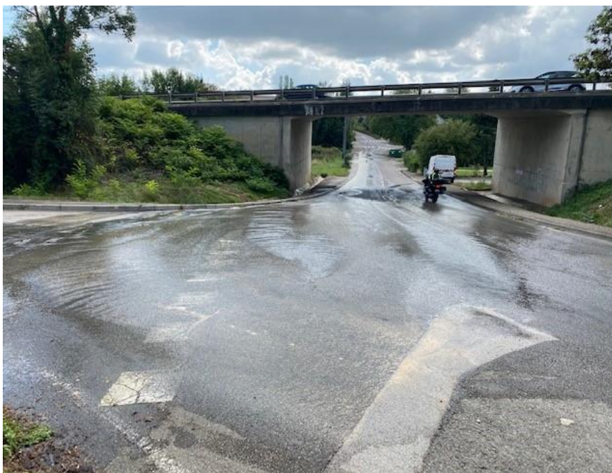
Septembre 2020 : Fuite d'eau au niveau du quartier de Landon / Chemin des Longeottes
